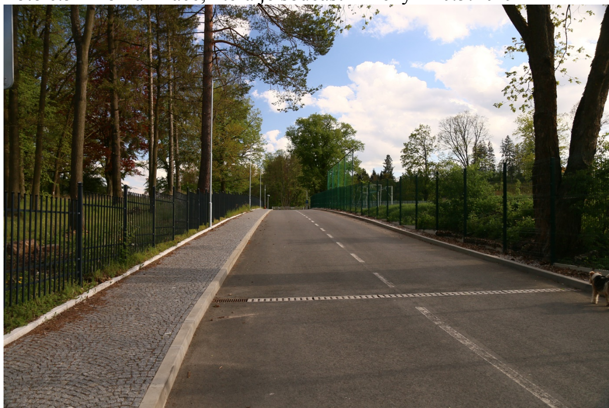
Foto č.6 – černá stavba komunikace, která je součástí změny - 10.5.2019
