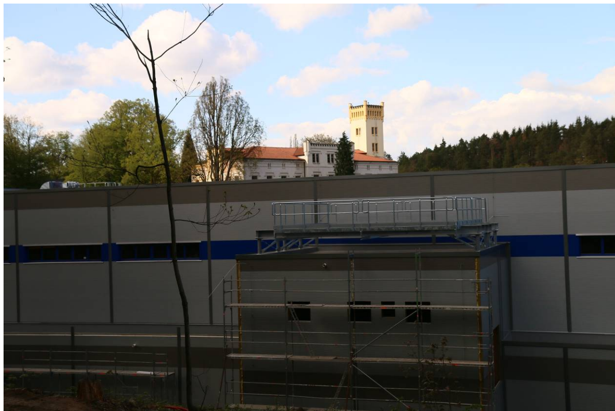
Foto č.10 – nová obrobna na parcele č.936 kú Těptín - 10.5.2019
